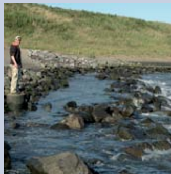
10 sec. De boot is inmiddels voorbij en het water zoekt zijn weg tussen de stenen door terug. Carl weet dat het gevaar nog niet geweken is.
